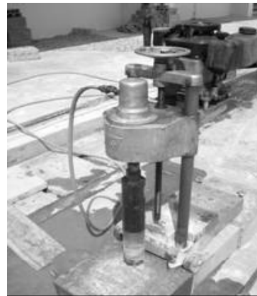
ภาพที่ 5 การเจาะแก่นตัวอย่างคอนกรีต
