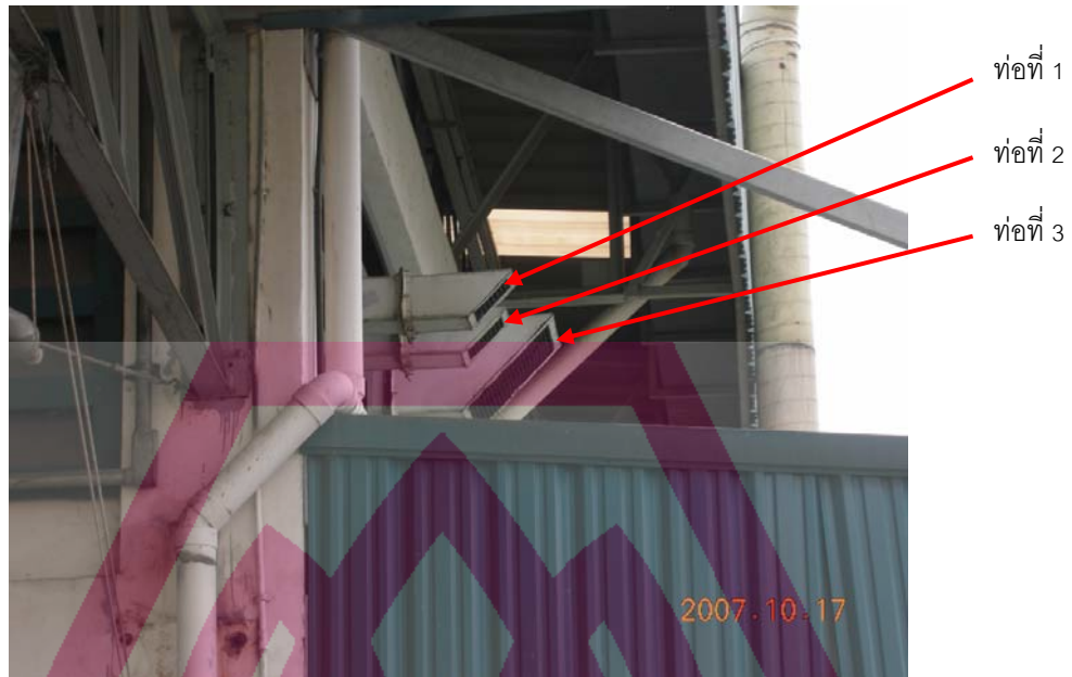
ภาพที่ 3-9 แสดงตำแหน่งท่อที่ปล่อยลมร้อนออกสู่บรรยากาศ
