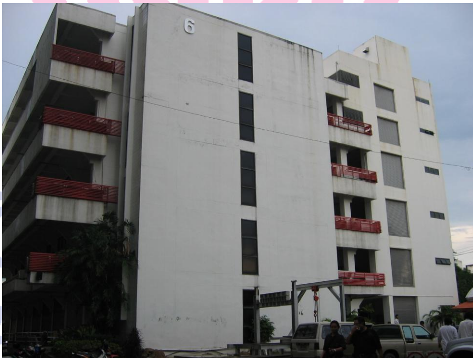
ภาพที่ 3.6 อาคารคณะวิศวกรรมศาสตร์ (อาคาร 6)
