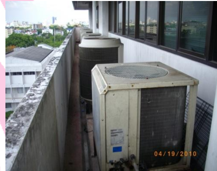
(ข) การติดตั้งคอยล์ร้อนในพื้นที่แคบ
