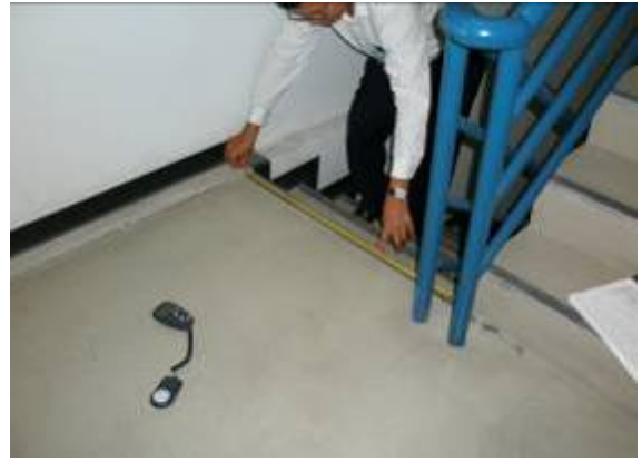
ภาพที่ 4.7 บันไดมีความกว้าง 110 เซนติเมตร
