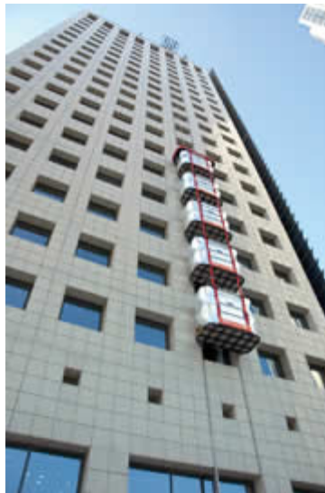
ภาพที่ 5.1 อุปกรณ์อพยพหนีไฟ Escape Rescue
