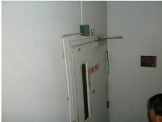
ภาพที่ 4.6 ประตูทำด้วยวัสดุทนไฟปิดได้เองเปิดออกสะดวก
