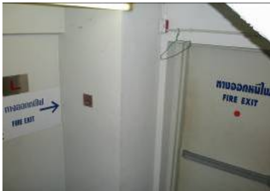
ภาพที่ 4.8 ไม่มีสายยู ห่วง โข่ กลอน
