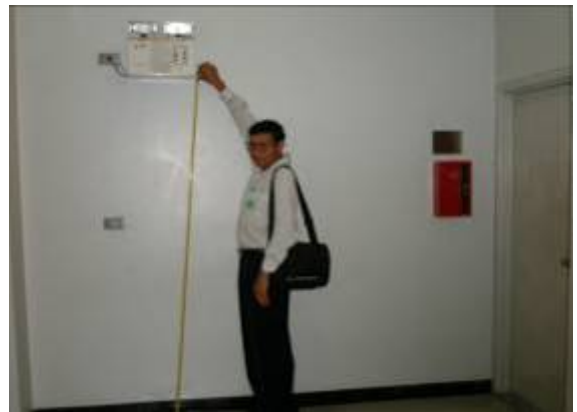
ภาพที่ 4.9 ตรวจสอบความสูง 2.20 เมตร
