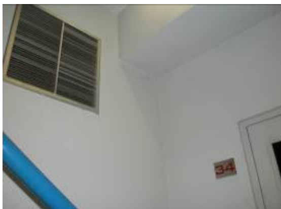
ภาพที่ 4.16 ช่องลมในช่องบันไดหนีไฟ
