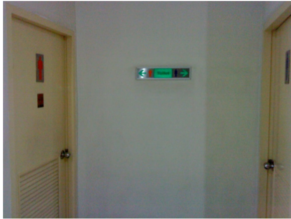
ห้องน้ำสระว่ายน้ำ
