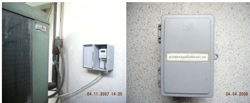
ภาพประกอบที่ ง.6 ตำแหน่งการติดตั้ง Weekly Programmable Time Switch ควบคุม เครื่องปรับอากาศแบบแยกส่วนของห้องบรรยาย 1-1204
