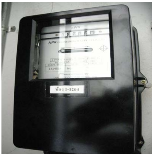
ภาพประกอบที่ ง.1 Kilowatt-hour meter ยี่ห้อ KPN ขนาด 15(45)A, 3x220/380V, 50Hz, 3P-4w Class:2.0
