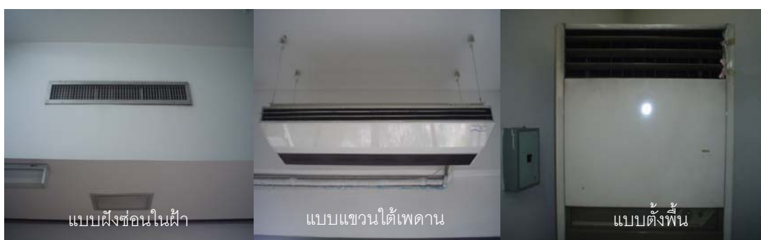
ภาพประกอบที่ 8 แฟนคอยล์ยูนิต (Fan Coil Unit) ของเครื่องปรับอากาศแบบแยกส่วน
