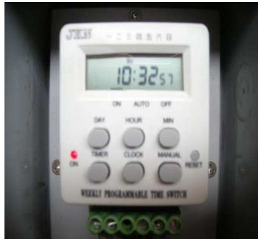
ภาพประกอบที่ ๓.3 Weekly Programmable Time Switch ยี่ห้อ JKN
