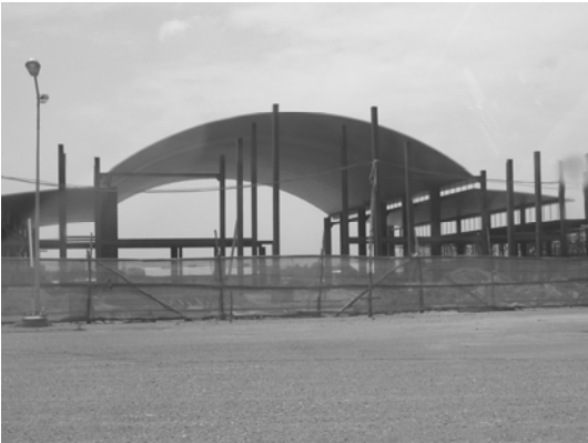
รูปที่ 1 หลังคาโค้งไร้โครงถักที่ติดตั้งในโครงการบางกอกเกตพลาซ่า หลังคาโค้งนี้ไม่ต้องใช้โครงถักจึงทำให้ดูโล่ง แต่มีความยาวช่วงสูงสุดที่ 24.4 เมตร (80 ฟุต)
