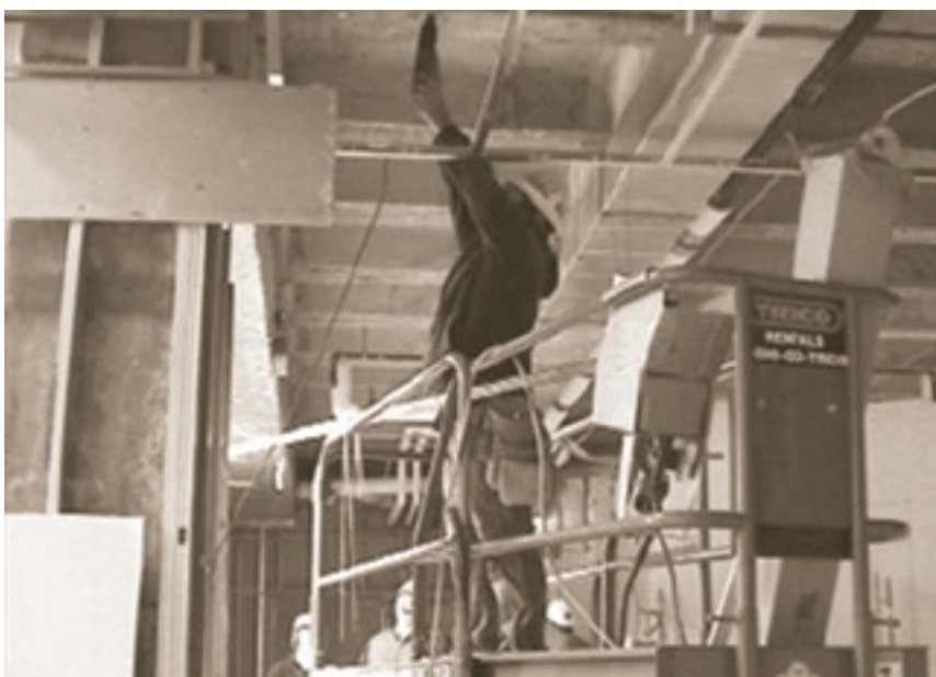
ทำงานยาก วิธีเจาะรูใต้พื้นคอนกรีตเดิม
