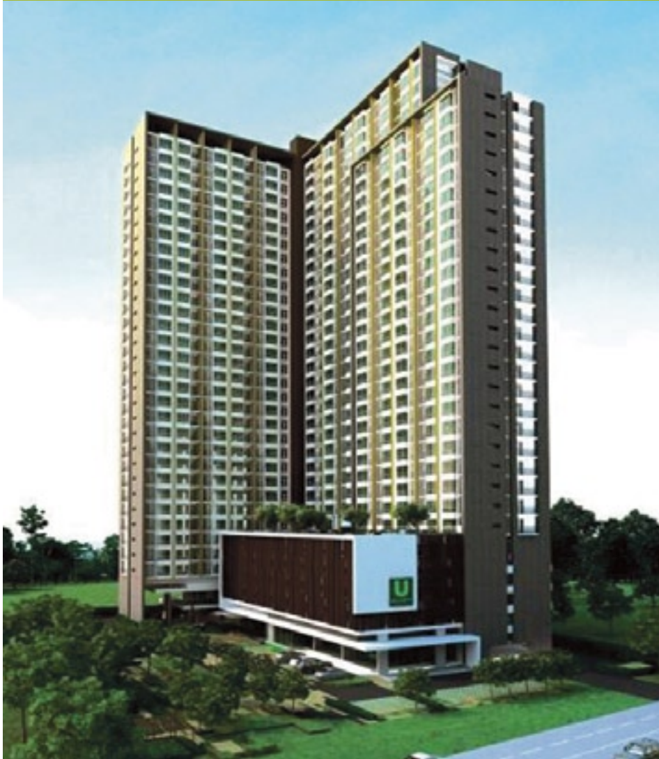
อาคารพักอาศัย 32 ชั้น ซอยอ่อนนุช กทม. สร้างเสร็จใน 13 เดือนได้อย่างไร
