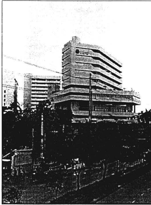
ภาพประกอบ ก.1 อาคาร 1 ด้านทิศเหนือ
