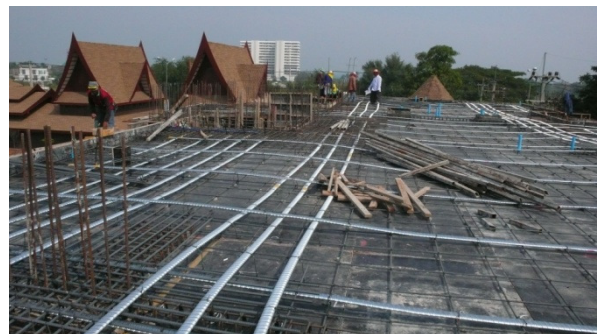
รูปที่ 3 ลวดอัดแรงในทอร้อยที่วางเสร็จแล้วบางส่วน (ภาพจากโครงการจริงที่ศึกษา)
