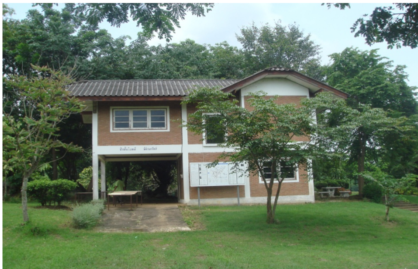
ภาพ สภาพด้านนอกของบ้านพักสำหรับนักท่องเที่ยว
