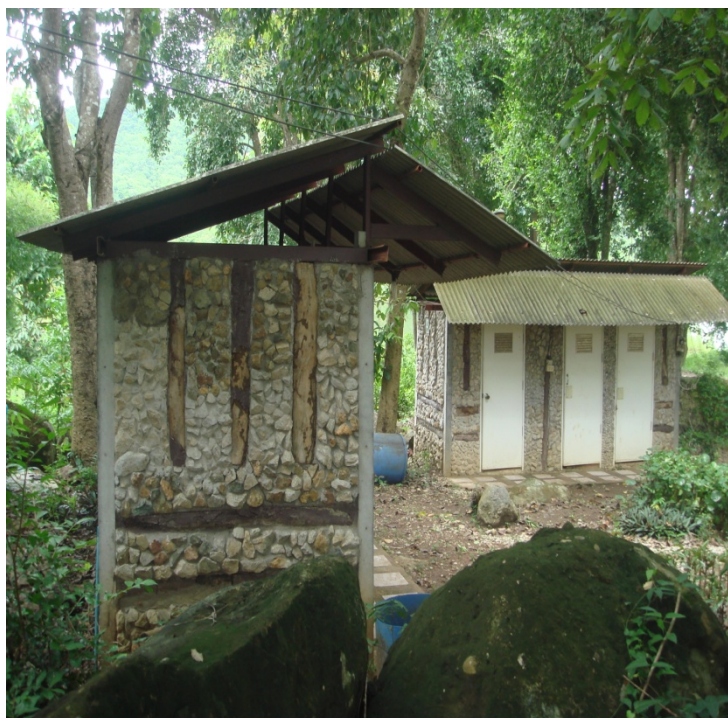
ภาพ สภาพห้องน้ำที่อยู่ภายในบริเวณอ่างเก็บน้ำเขาสามสืบ
