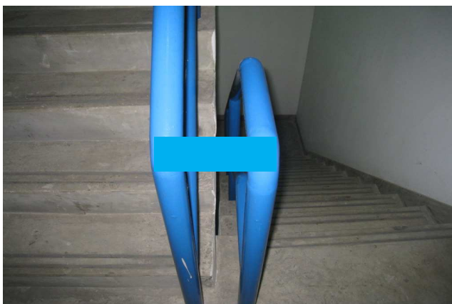
ภาพประกอบที่ 4.2.1.3 การเชื่อมต่อราวบันไดภายในช่องทางหนีไฟให้ต่อเนื่องกัน
