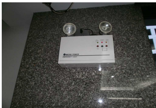
ภาพประกอบที่ 4.1.9 สายฉีดของถังดับเพลิงและไฟสำรองฉุกเฉินชนิดมีแบตเตอรี่ในตัว
