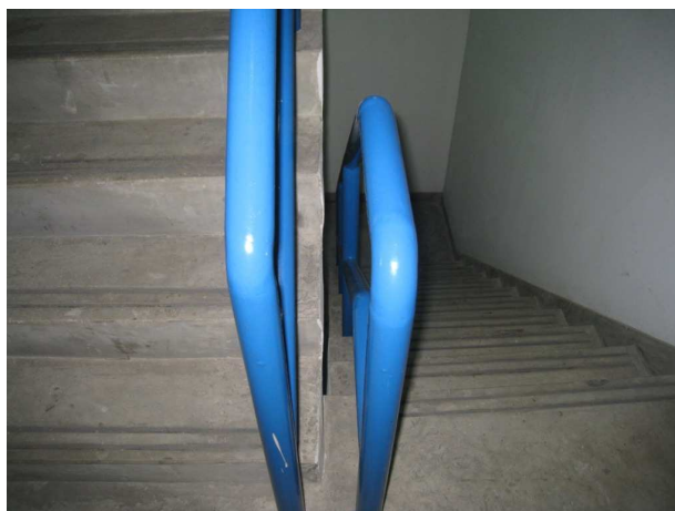
ภาพประกอบที่ 4.1.12 ราวจับบันไดหนีไฟ
