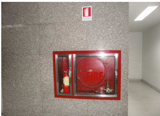
ภาพประกอบที่ 4.1.9 สายฉีดของถังดับเพลิงและไฟสำรองฉุกเฉินชนิดมีแบตเตอรี่ในตัว
