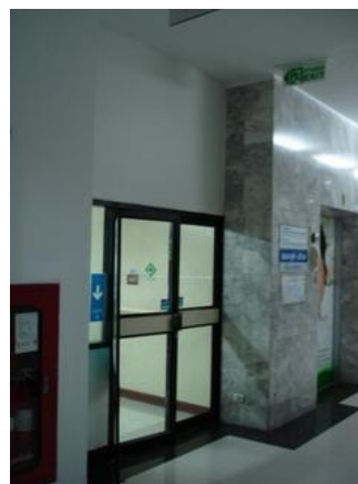
ภาพประกอบที่ 4.3 ประตูบันไดหนีไฟเป็นบานกระจกบานตลอดบานและปิดไม่สนิท
