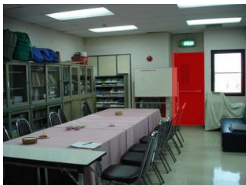
ภาพประกอบที่ 4.9 ผนังคอนกรีต 10 เซนติเมตร เพื่อขยายความกว้างของประตุนีไฟ
