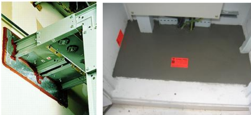
ภาพประกอบที่ 4.2 ตัวอย่างการติดตั้งวัสดุป้องกันไฟลาม ที่ผนังและพื้นช่องงานระบบ
