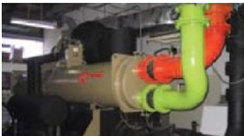
ภาพประกอบที่ 3 การเปลี่ยนเครื่องทำน้ำเย็น (Chiller) โรงแรมโนโวเทล สยามสแควร์
