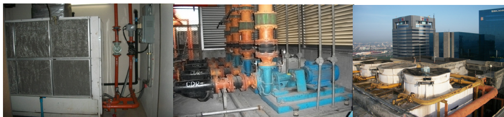
ตารางที่ 2 ตารางแสดงเครื่องจักรที่ทำงานในระบบปรับอากาศแบบ PACKAGE WATER COOLED
