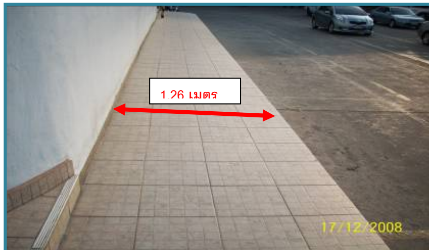
ภาพที่ 5.5 แสดงพื้นทางเดินรอบอาคาร
