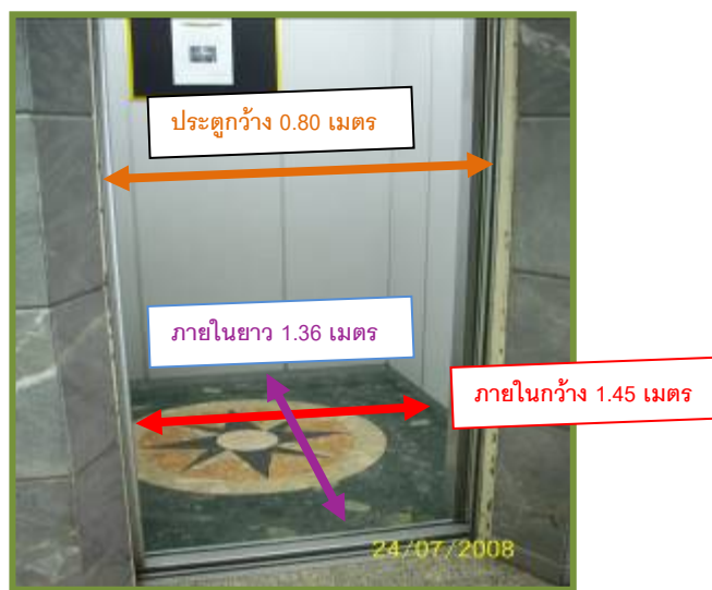
ภาพที่ 5.8 แสดงลิฟท์อาคาร
