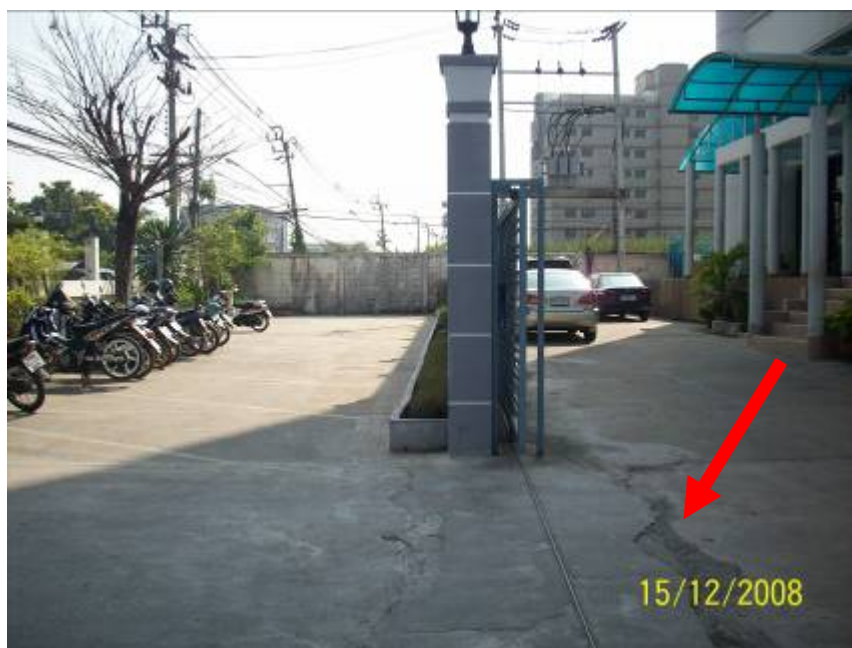
ภาพที่ 5.3 แสดงพื้นผิวถนนทางเข้าอาคาร
