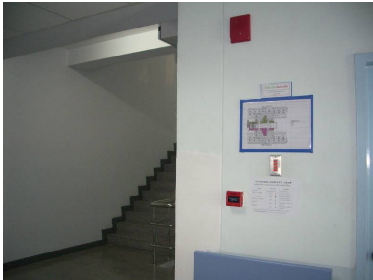
รูป 4.15 อุปกรณ์ส่งสัญญาณเสียงแจ้งเตือนอัตโนมัติและอุปกรณ์ส่งสัญญาณด้วยมือ(manual)
