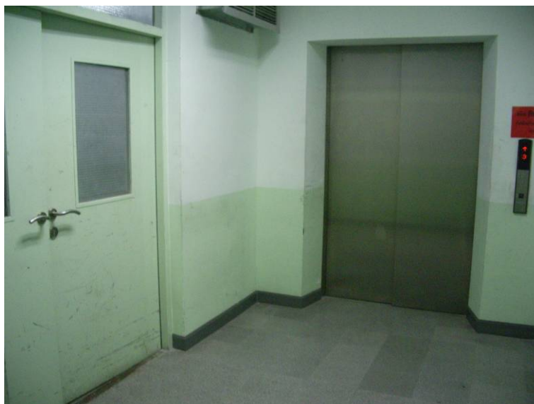
รูปที่ 4.11 โถงหน้าลิฟต์ดับเพลิงพร้อมประตูกันควัน
