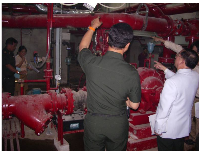
รูปที่ 4.19 การตรวจรับงานระบบดับเพลิง
