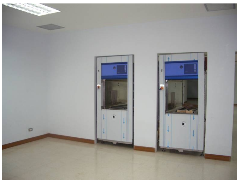
รูปที่ 4.28 เครื่องนึ่งฆ่าเชื้อโรค (Autoclave) แผนก CSSD ชั้น 9
