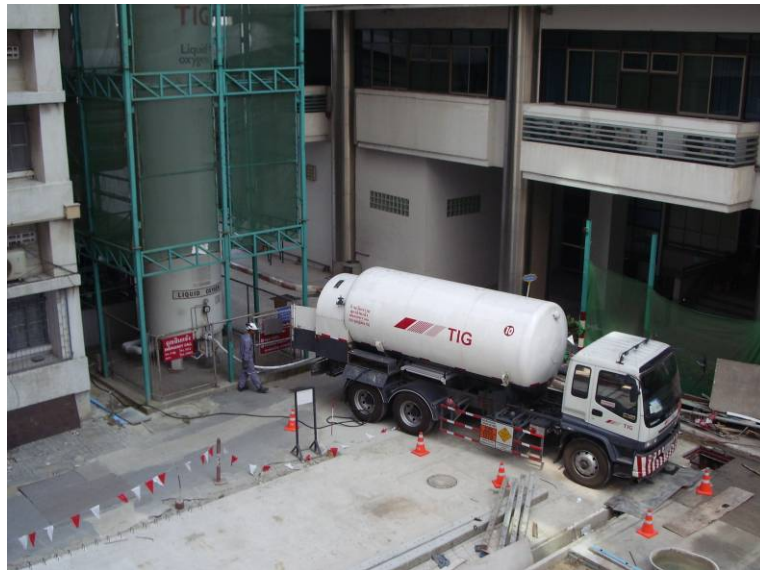
รูป 4.20 การจัดส่งก๊าซออกซิเจนเข้าถังเก็บซึ่งติดตั้งภายนอกอาคาร
