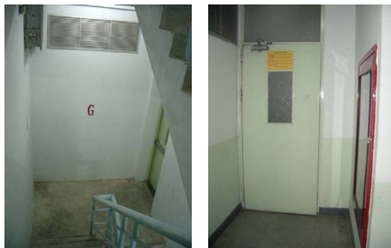
รูปที่ 4.6 บันไดหนีไฟและประตูหนีไฟชั้นล่าง
