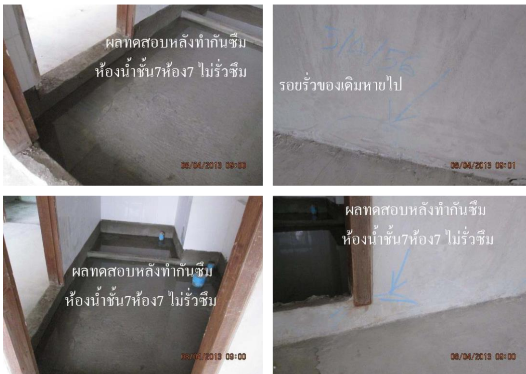
ภาพประกอบที่ 4.4 รูปแสดงผลการทดสอบน้ำ ทดสอบ กันซึมชนิด contite flex
