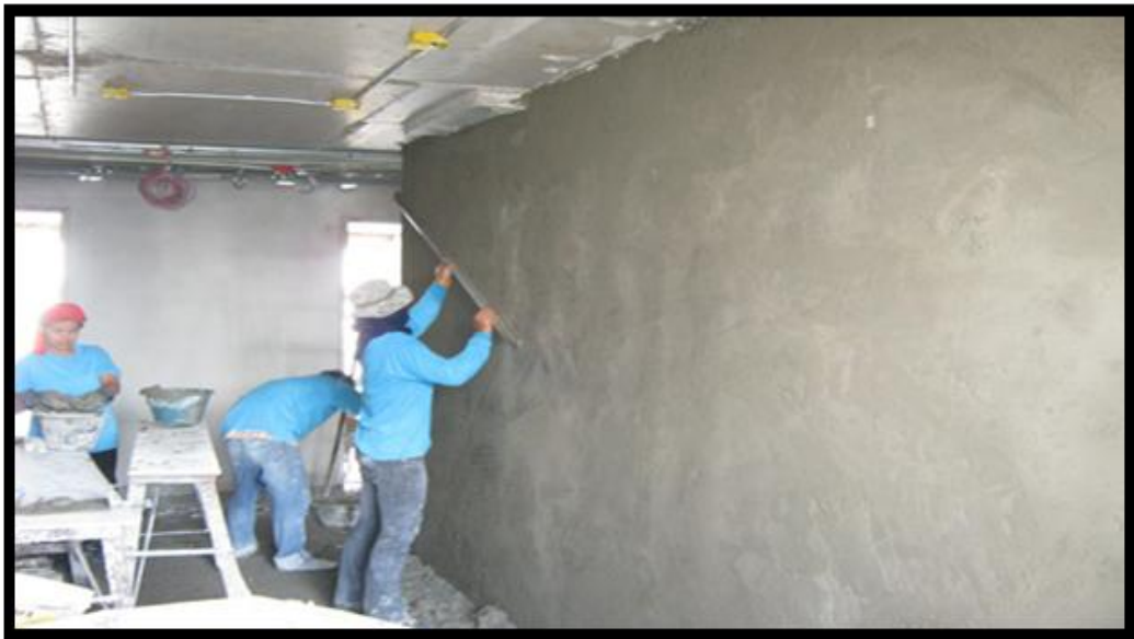
ภาพประกอบที่ 1.1 ปัญหาระบบผนังอิฐมอญที่ต้องใช้เวลาในการฉาบผนัง
