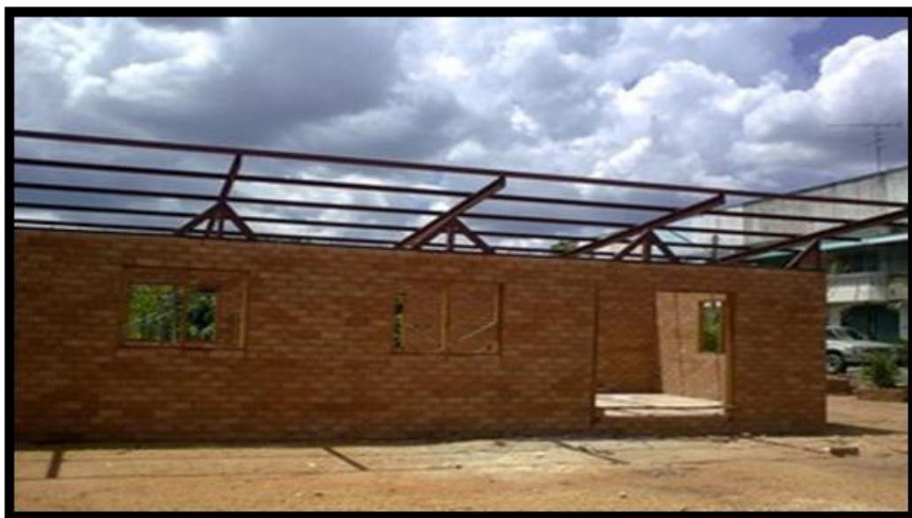
ภาพประกอบที่ 1.2 ระบบผนังอิฐประสานที่ไม่ต้องการการฉาบปูน
