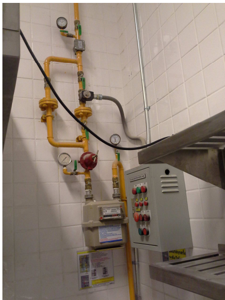
ภาพประกอบที่ 1.10 ส่วนงานระบบปรับอากาศและไฟฟ้า
