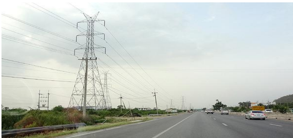
ภาพที่ 2.14 สายส่งไฟฟ้าย่อย (Sub Transmission Line)
