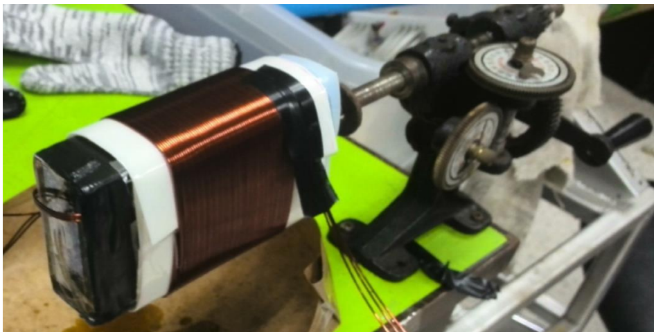
ภาพที่ 3.12 การพันหม้อแปลงไฟฟ้าแรงดันสูง
