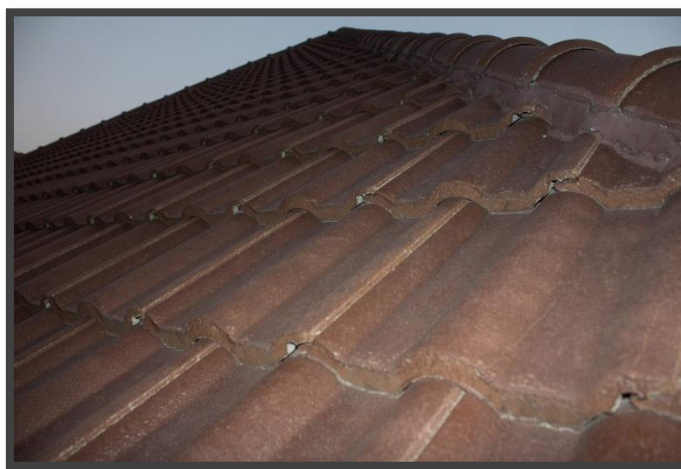
ก. ภาพหลังคาที่ต้องการวัดมุมอะซิมุท
