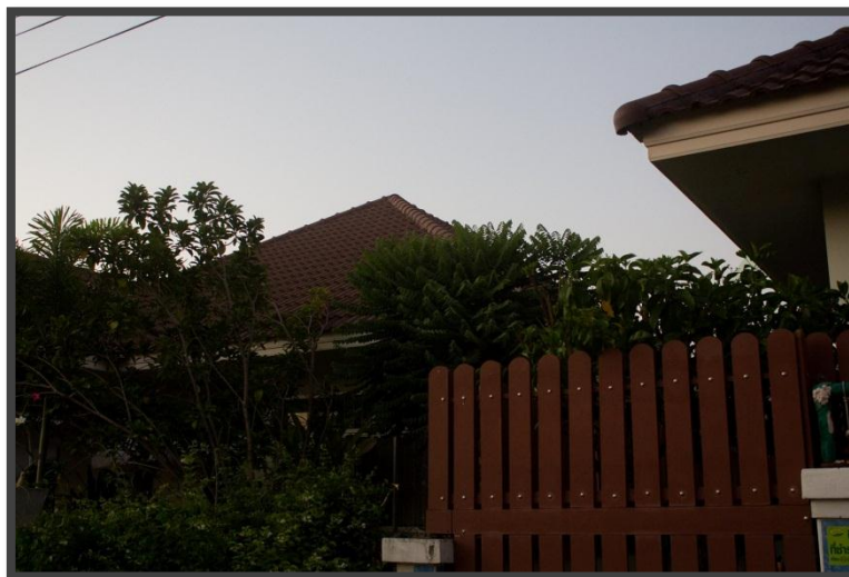
ภาพที่ 4.23 หลังคาทรงปั้นหยาบ้านที่ต้องการติดตั้งโซล่าเซลล์
