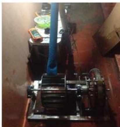
ภาพที่ 4.12 แสดงการติดตั้งเครื่องกำเนิดไฟฟ้าในรูปแบบกึ่งहनน้ำ
