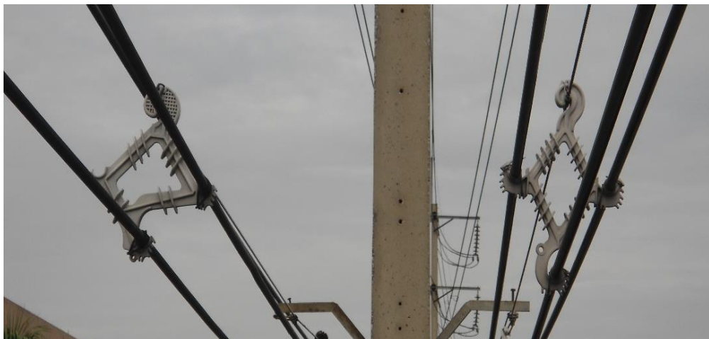
ภาพที่ 3.11 การใช้งานของเคเบิลสเปเซอร์ชนิด HDPE
