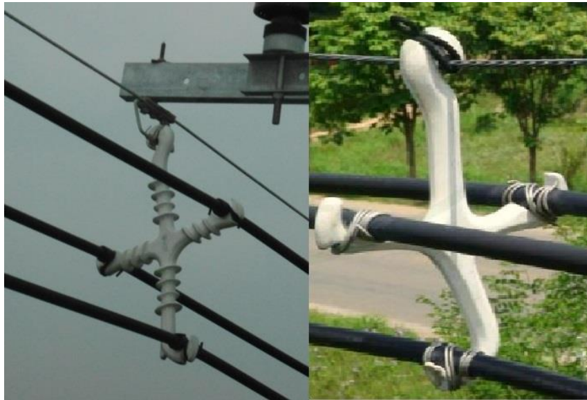
ภาพที่ 3.12 การใช้งานของเคเบิลสเปเซอร์ชนิด พอร์ซเลน
