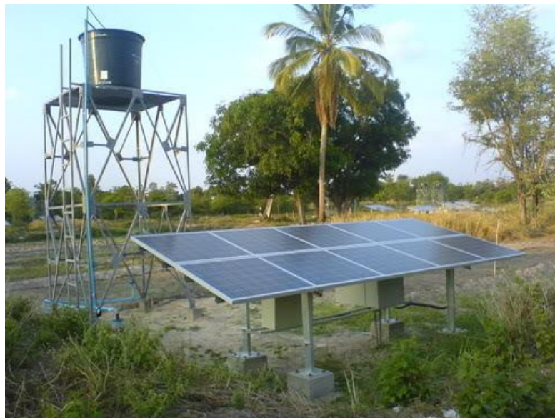
ภาพที่ 2.12 เซลล์แสงอาทิตย์จ่ายพลังงานเพื่อการสูบน้ำไปกับไว้ในถ้ำน้ำ
