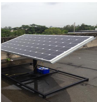
ก. แผงโซลาร์เซลล์คาดฟ้าอาคารคณะวิศวกรรมศาสตร์ ข. โคมหลอด LED ข้างอาคารคณะวิศวกรรมศาสตร์ ภาพที่ 3.4 โครงสร้างและการติดตั้งที่คาดฟ้าอาคารคณะวิศวกรรมศาสตร์มหาวิทยาลัยศรีปทุม
