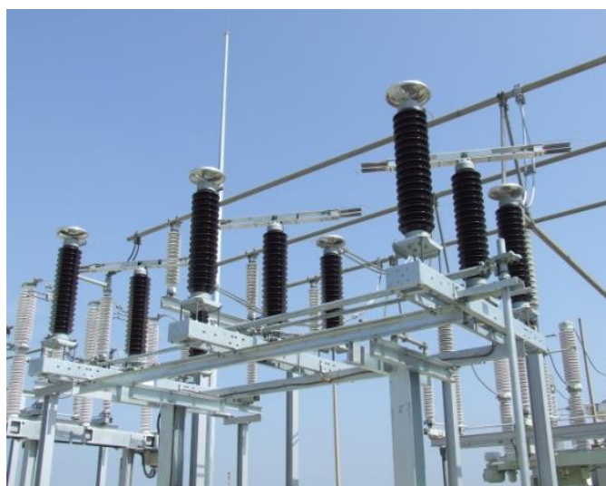
ภาพที่ 4.5 ภาพสวิตช์ปลดวงจรไฟฟ้าแรงสูง
