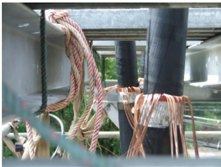
ภาพที่ 4.3 ลักษณะกราวด์ของสายเคเบิลแรงสูง
