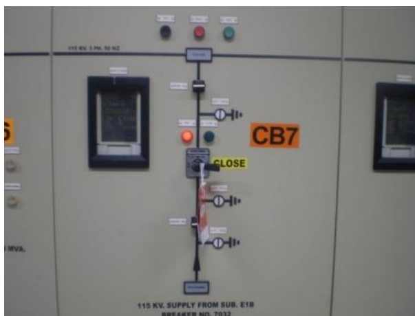
ภาพที่ 4.7 ป้ายสัญลักษณ์ห้ามใช้งาน (Red Tag)
