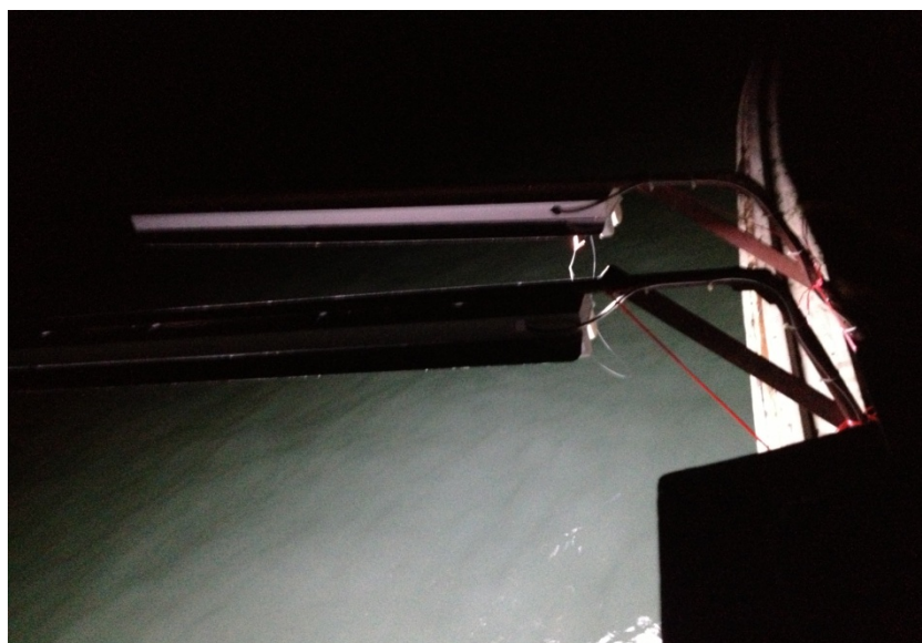
ภาพที่ 3.8 ติดตั้งโคมไฟหลอด LED จำนวน 2 โคม
