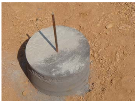
ภาพที่ 4.3 แสดงการหล่อตัวลดความต้านทานห่อหุ้มบริเวณด้านล่างของแท่งตัวนำ
