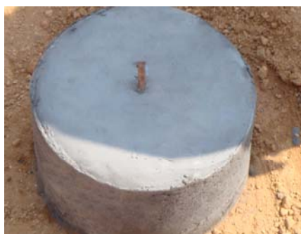
ภาพที่ 4.1 แสดงการหล่อตัวลวดความต้านทานห่อหุ้มบริเวณด้านบนของแท่งตัวนำ
