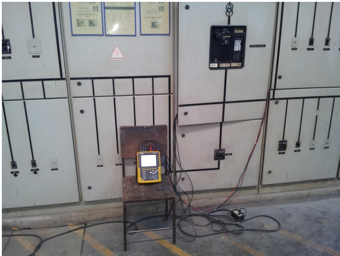
ภาพที่ การติดตั้งเครื่องมือวัด
