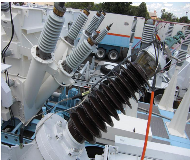
ภาพที่ 3.13 การเชื่อมต่อ Ground ของเครื่องมือวัดเข้ากับระบบ
