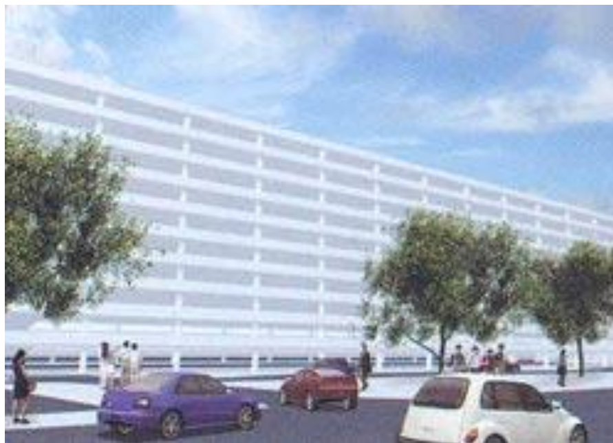
ภาพประกอบที่ 4 อาคารจอดแล้วจร
