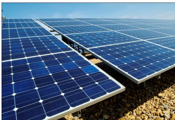
รูปที่ 2.5 แสดงรูปแผง Solar Cell
