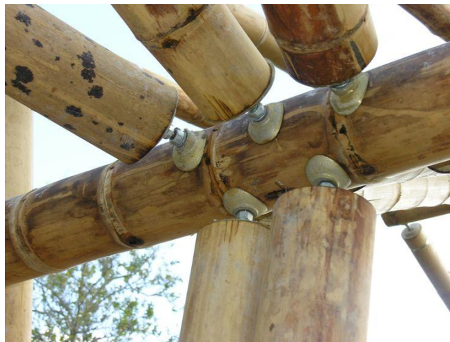
ภาพที่ 3.4 : แสดงวัสดุและรายละเอียดการต่อโครงสร้างกับวัสดุสมัยใหม่
