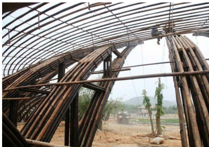
ภาพที่ 3.3 : แสดงวัสดุและรายละเอียดการต่อโครงสร้างแบบธรรมชาติ
