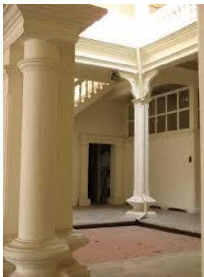
รูปที่ 2.62 การเปิดคอร์ตกลางอาคารเรียนเก่า
