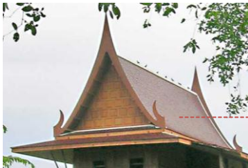
รูปภาพที่ 4.22 ลักษณะหลังคาทรงจั่ว
