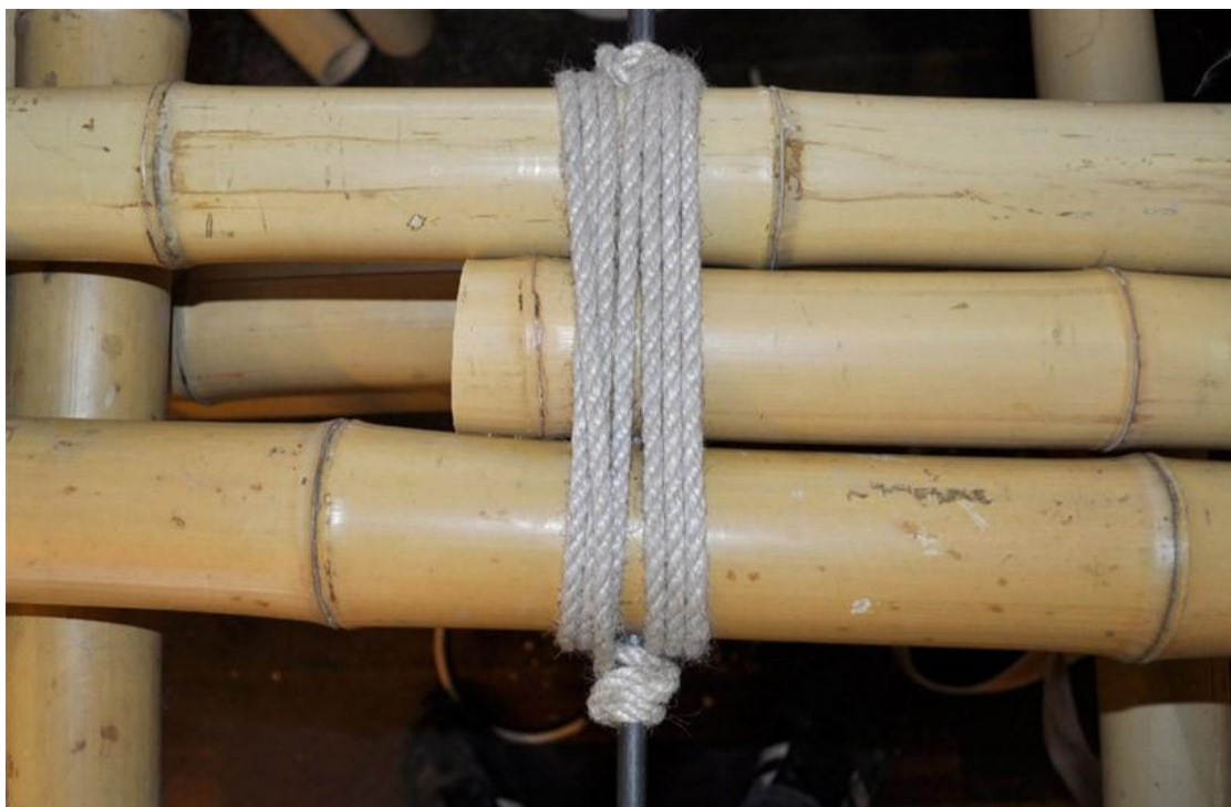
รูปภาพที่ 3.5 โครงสร้างอาคารระบบ การผูกไม้ไผ่
