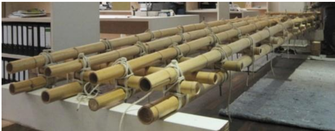
รูปภาพที่ 3.6 โครงสร้างอาคารระบบ การผูกไม้ไผ่
