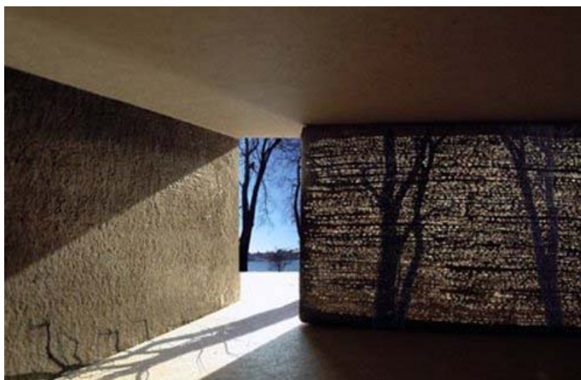
รูปที่ 4.25 แสดงภาพของปูนซีเมนต์โปร่งแสง
