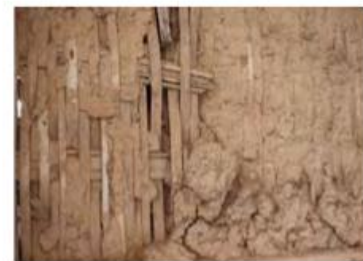
ภาพที่ 15 ดินฉาบยุงข้าวผสมซีเมนต์และแกลบที่บ้านทะเล หมู่ 4 ตำบลเสมา อำเภอสูงเนิน จังหวัดนครราชสีมา ที่มา : จากการสำรวจ, 2546 4.2 บ้านดินในอดีต
