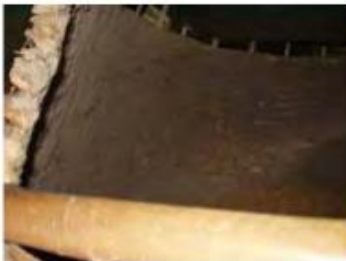
ภาพที่ 13 สภาพภายในของเสวียนที่ใช้ดินผสมขี้ควาย มาฉาบปิดโครงไม้ไผ่ให้เรียบเพื่อเก็บ ข้าวเปลือก ตำบลบ้านใหม่ อำเภอลำครบุรี จังหวัดนครราชสีมา ที่มา : จากการสำรวจ, 2546
