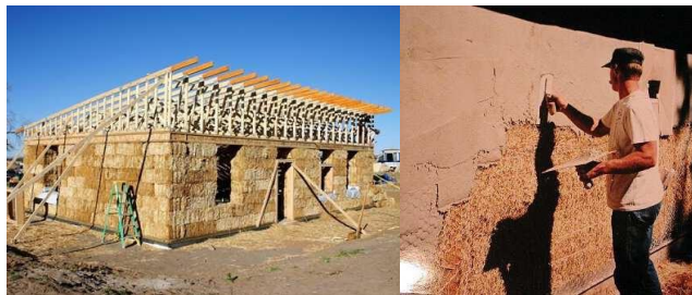
ภาพที่ 44 การก่อสร้างโดยใช้ฟางก่อบด้วยดิน
