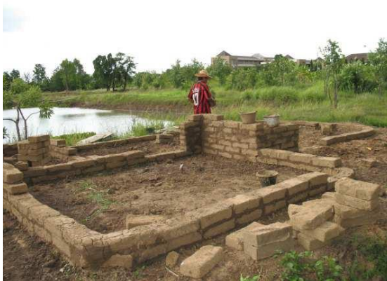
ภาพที่ 38 การก่ออิฐดินดิบ
