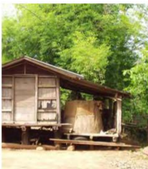
ภาพที่ 12 เสวียน สิ่งปลูกสร้างชั่วคราวสำหรับเก็บข้าวเปลือกที่บ้านเฉลียง ตำบลเฉลียง อำเภอครบุรีจังหวัดนครราชสีมา :
