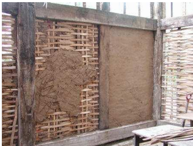
ภาพที่ 40 การปั้นผนังกับโครงไม้
