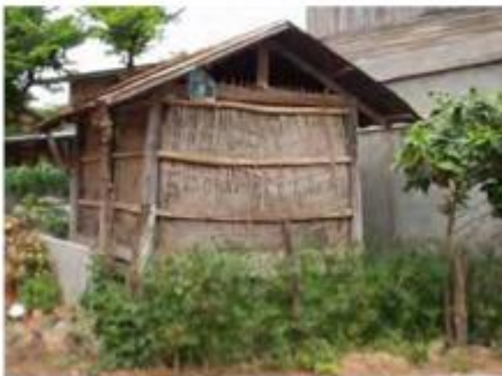
ภาพที่ 14 ยุ้งข้าวโครงไม้จริง โครงผนังไม้รวกฉาบดินผสมขี้ควายและแกลบ หลังคาจั่วมุงสังกะสี อยู่ที่บ้านทะเลหมู 4 ตำบลเสมา อำเภอสว่างแดนดินจังหวัดนครราชสีมา ที่มา : จากการสำรวจ, 2546
