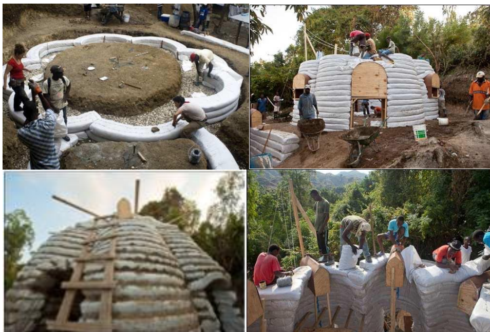
ภาพที่ 43 การก่อสร้างโดยใช้กระสอบ
