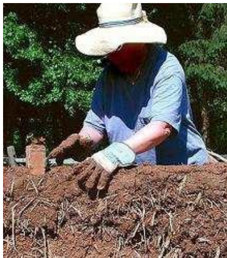
ภาพที่ 39 การปั้นผนัง
