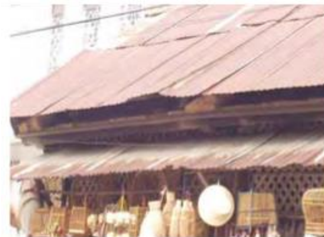
ภาพที่ 23 หลังคาสองชั้นของบ้านที่ช่วยระบายความร้อน อำเภอเมือง จังหวัดอุบลราชธานี ที่มา : จากการสำรวจ, 2546
