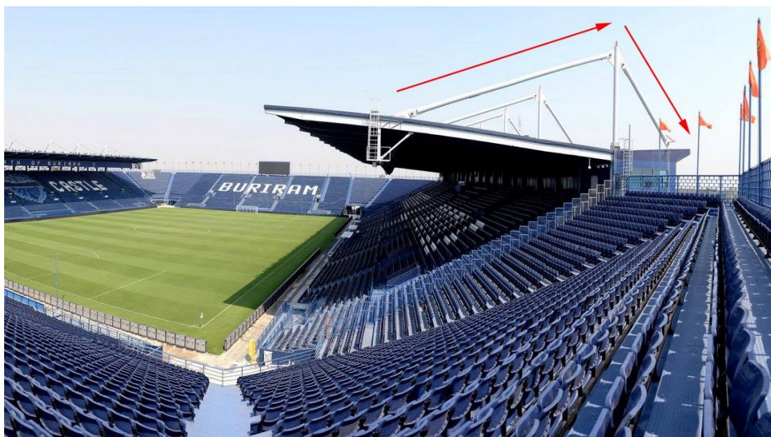
ภาพที่ 1.8. ระบบโครงสร้างหลังคา
