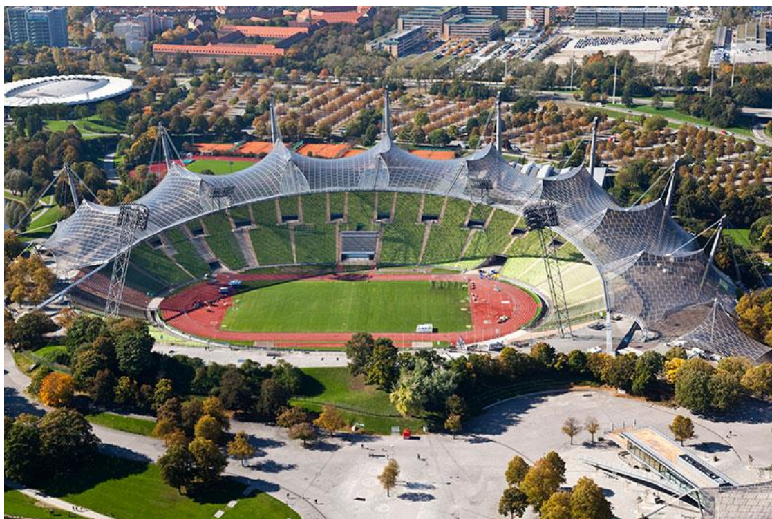
ภาพที่ 2.3 โครงสร้างแบบเต็นท์หรือแบบแผ่นผ้าใบ (Fabric tents)
