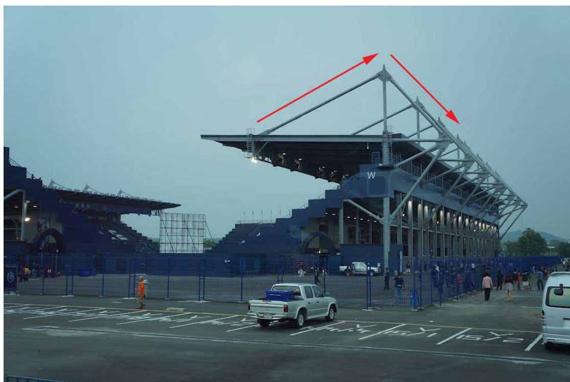
ภาพที่ 1.7 ระบบโครงสร้างหลังคา
