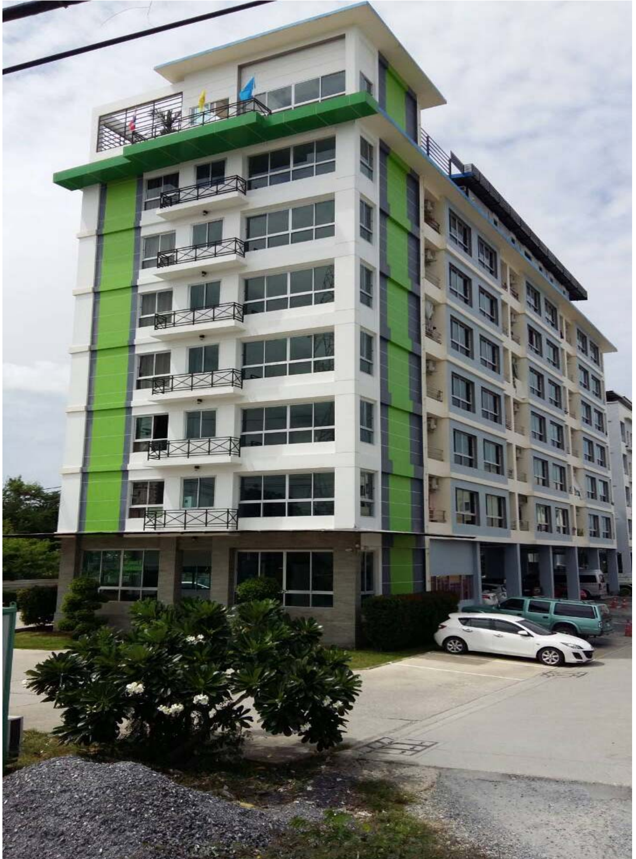
งานอพาร์ทเมนท์ 7 ชั้น เทพารักษ์ กม.12.
