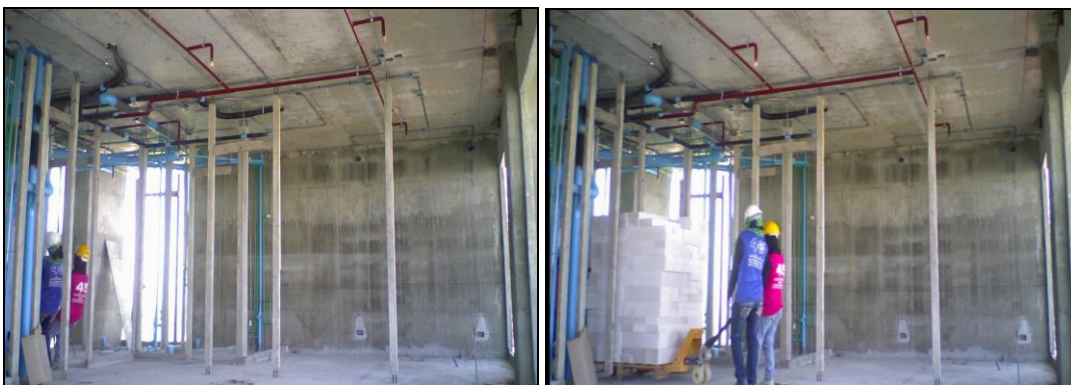
ภาพประกอบที่ 3.4 แสดงการขนอิฐของแรงงานที่ “มีการวางแผนงานจากผู้วิจัย”
