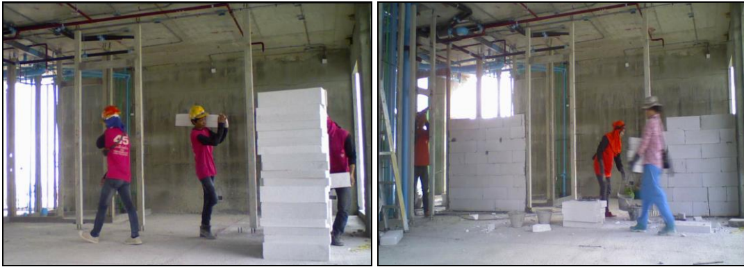
ภาพประกอบที่ 3.3 แสดงการขนอิฐของแรงงานที่ “ไม่มีการวางแผนงานจากผู้วิจัย”
