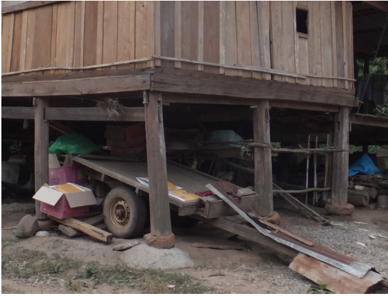
ภาพที่ 4: ขางก้อมและขางล่วง เรือนนายสนุก หุมอาจ บ้านนาหอ ต.นาหอ อ.ด่านซ้าย จ.เลย
