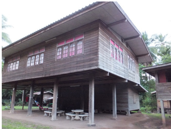
ภาพที่ 19: คานตงของเรือนไม้ร่วมสมัย เรือนนายชำนาญ เครือหงษ์ บ้านนาเบ็ญ ต.นาหอ อ.ด่านซ้าย จ.เลย สังเกตได้อย่างชัดเจนว่าเรือนหลังนี้วางคานไว้ในแนวยาวของเรือน แทนที่จะวางในแนวสัด
