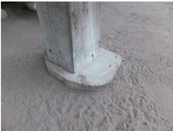
ภาพที่ 18: เสาเรือนฝังดินของเรือนไม้ร่วมสมัย เรือนนายชำนาญ เครือหงษ์ บ้านนาเบ็ญ ต.นาหอ อ.ด่านซ้าย จ.เลย
