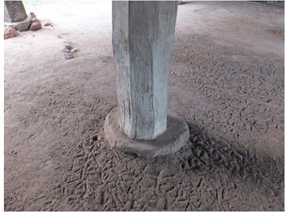
ภาพที่ 13: ฐานเสาของเรือนเสายองหิน เรือนนายฉลาด เหมือนศรีชัย บ้านนาเบ็ย ต.นาหอ อ.ด่านซ้าย จ.เลย
