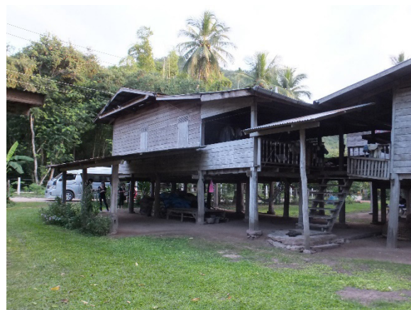
ภาพที่ 11: เรือนนายฉลาด เหมือนศรีชัย บ้านนาเบี้ย ต.นาหอ อ.ด่านซ้าย จ.เลย แสดงให้เห็นการต่อเติมหลังคาคลุมชานเดิม
