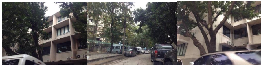
ภาพที่ 4.5 ภาพด้านทิศเหนือของโครงการ
