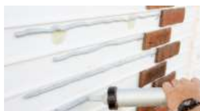
รูปภาพที่ 2.38 ชั้นตอนที่ 2 ทากาวบน Composite backer panels
