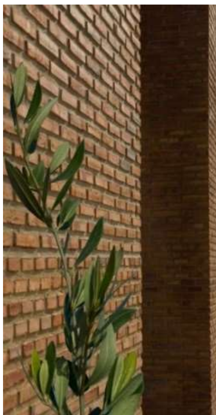
รูปภาพที่ 2.79 รูปแบบการทำเปลือกอาคารแบบ ก่ออิฐโชว์แนว ที่มา http://www.google.com/Brick/detail/facade
