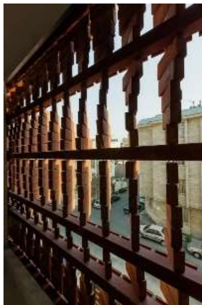
รูปภาพที่ 2.78 ตัวอย่างการใช้เทคนิคแบบแห้ง ในการสร้างเปลือกอาคาร ที่มา http://www.google.com/Brick/detail/facade
