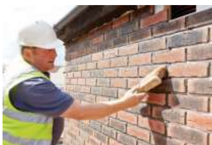
รูปภาพที่ 2.42 ทำความสะอาดโดยใช้แปรงขัด ที่มา http://www.google.com/Brick/brickslip
