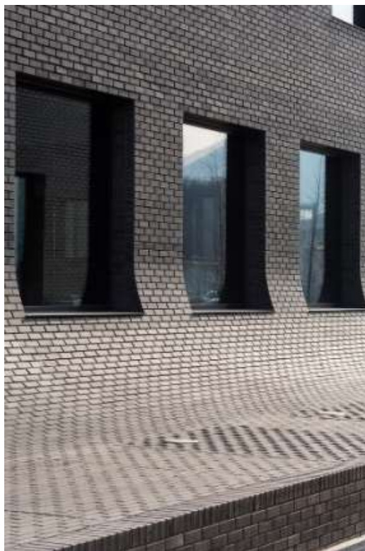
รูปภาพที่ 2.76 รูปแบบการทำเปลือกอาคารแบบ Continually ที่มา http://www.google.com/Brick/detail/facade
