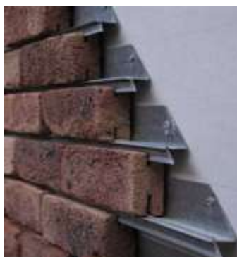
รูปภาพที่ 2.43 เทคนิคการเซาะร่องอิฐ ที่มา http://www.google.com/Brick/detail
