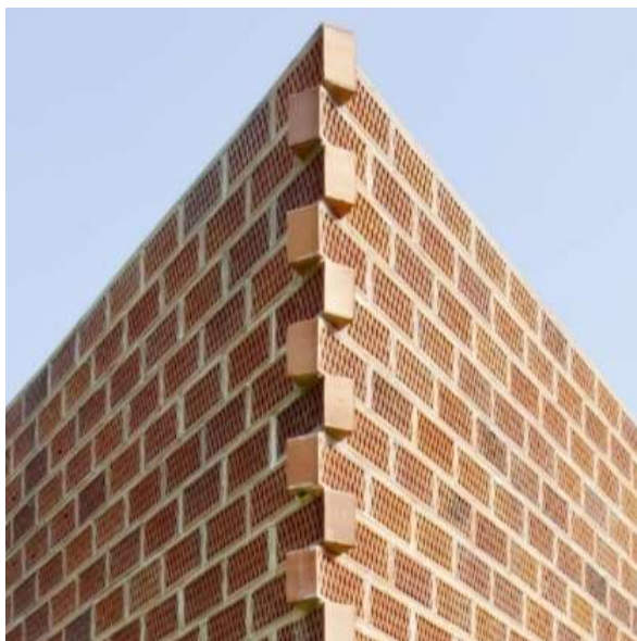
รูปภาพที่ 2.82 รูปแบบการทำเปลือกอาคารแบบชั้นและขัดกัน ที่มา http://www.google.com/Brick/detail/facade
