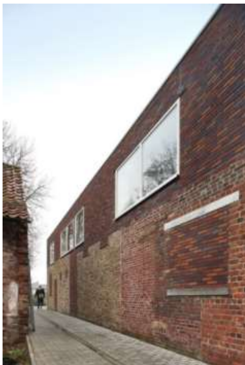
รูปภาพที่ 2.84 รูปแบบการทำเปลือกอาคารแบบการปะ ที่มา http://www.google.com/Brick/detail/facade
