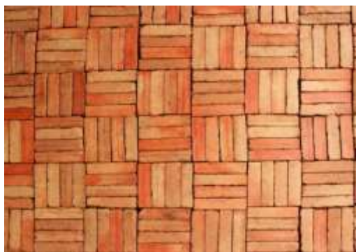
รูปภาพที่ 2.66 รูปแบบการเรียงอิฐบนพื้นโดยเรียงแบบลักษณะคล้ายการสาน ที่มา http://www.google.com/Brick/bond
