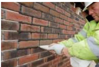
รูปภาพที่ 2.40 ใช้มอร์ตาร์หรือน้ำยาเฉพาะ อุดช่องว่างระหว่างแผ่นอิฐ(JOINT)
