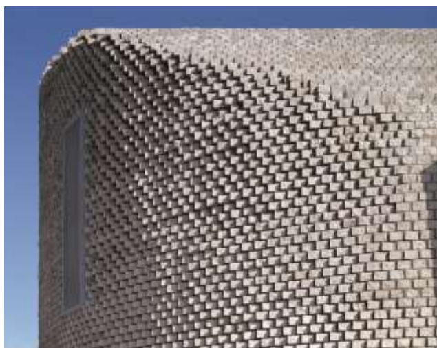
รูปภาพที่ 2.77 รูปแบบการทำเปลือกอาคารแบบ พิกซ์เซลล์ท์ ที่มา http://www.google.com/Brick/detail/facade
