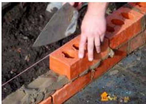
รูปภาพที่ 2.34 การก่อแบบเปียก ที่มา http://www.google.com/Brick/
