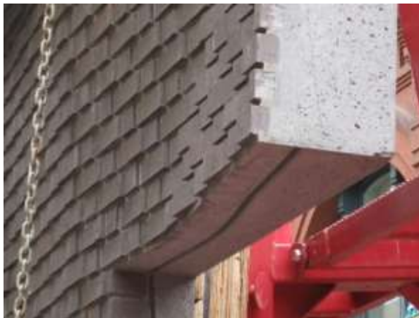
รูปภาพที่ 2.86 เทคนิคการนำอิฐไปแปะกับผนังสำเร็จ ที่มา http://www.google.com/Brick/detail/facade
