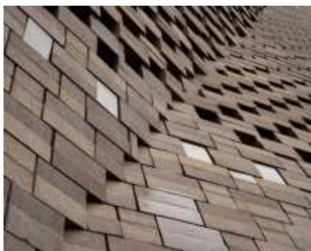
รูปภาพที่ 2.88 การใช้เทคนิคอิฐและโบลท์ ที่มา http://www.google.com/Brick/detail/facade
