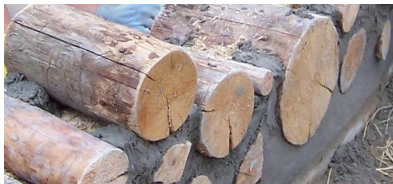
รูปที่ 2.9 การใช้เศษไม้ก่อด้วยดินเหนียว (Cordwoodmasonry, 2017)
