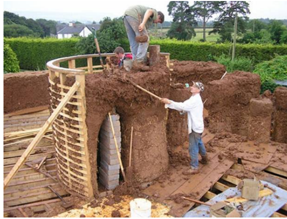
รูปที่ 2.6 แสดงการปั้นดินเป็นผนังโดยการผสมเศษเหลือใช้ทางการเกษตร (Pinterest, 2017)
