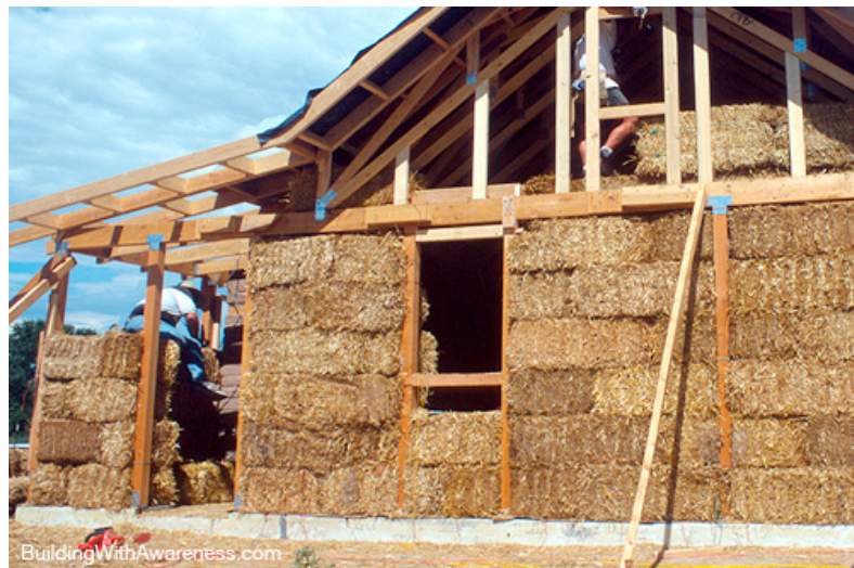
รูปที่ 3.14 รูปแบบการใช้ฟางอัดก้อนบนด้วยดิน (Punpunthailand, 2017)
