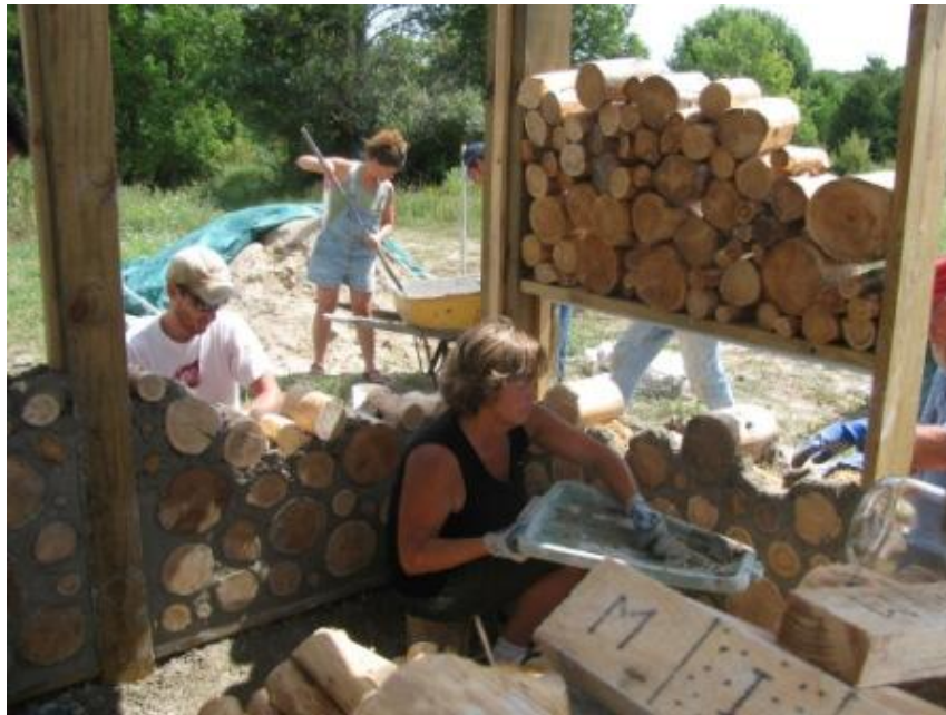
รูปที่ 2.10 การใช้เศษไม้ก่อด้วยดินเหนียว (Cordwoodmasonry, 2017)
