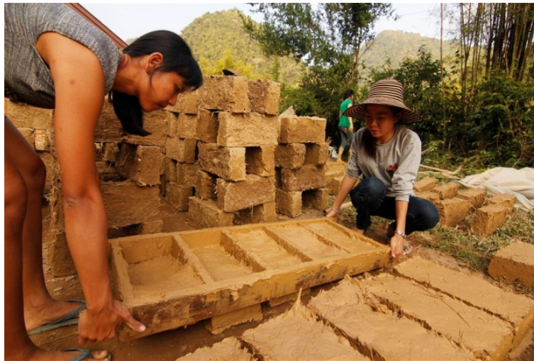
รูปที่ 3.8 การปั้นอิฐดินดิบ (Aod-Ayuda, 2017)
