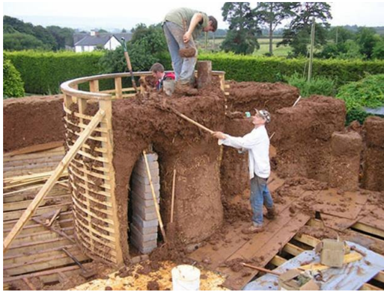
รูปที่ 3.9 แสดงการปั้นดินเป็นผนังโดยการผสมเศษเหลือใช้ทางการเกษตร (Pinterest, 2017)
