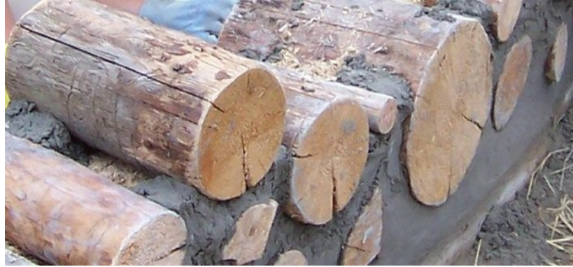
รูปที่ 3.11 การใช้เศษไม้ก่อด้วยดินเหนียว (Cordwoodmasonry, 2017)
