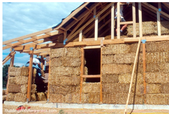
รูปที่ 2.16 รูปแบบการใช้ฟางอัดก้อนฉาบด้วยดิน (Thai-Punpunthailand, 2017)
