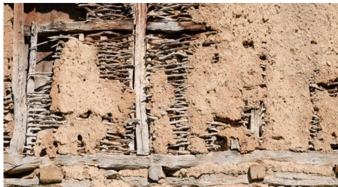
รูปที่ 3.10 การปั้นดินกับโครงไม้สาน (Motherearthnews, 2017)
