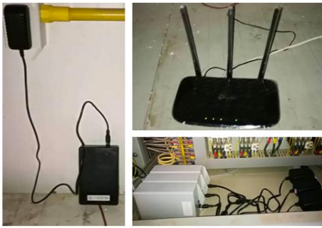
รูปที่ 5 การติดตั้งอุปกรณ์บริเวณห้องแช่
