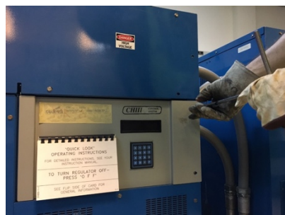
รูปที่ 9 ตู้ควบคุมการจ่ายกระแสแบบคงที่ (Constant Current Regulator : CCR)
