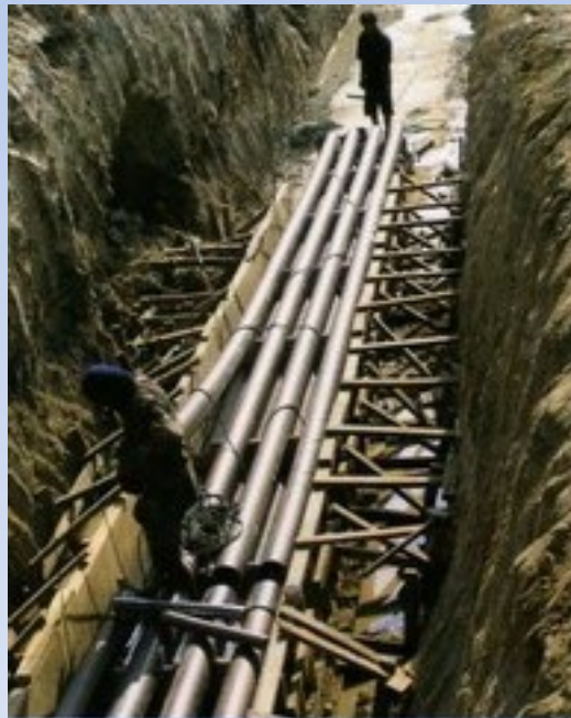
ใช้ในงานท่อร้อยสายไฟฟ้า สายเคเบิล (Conduit System)
